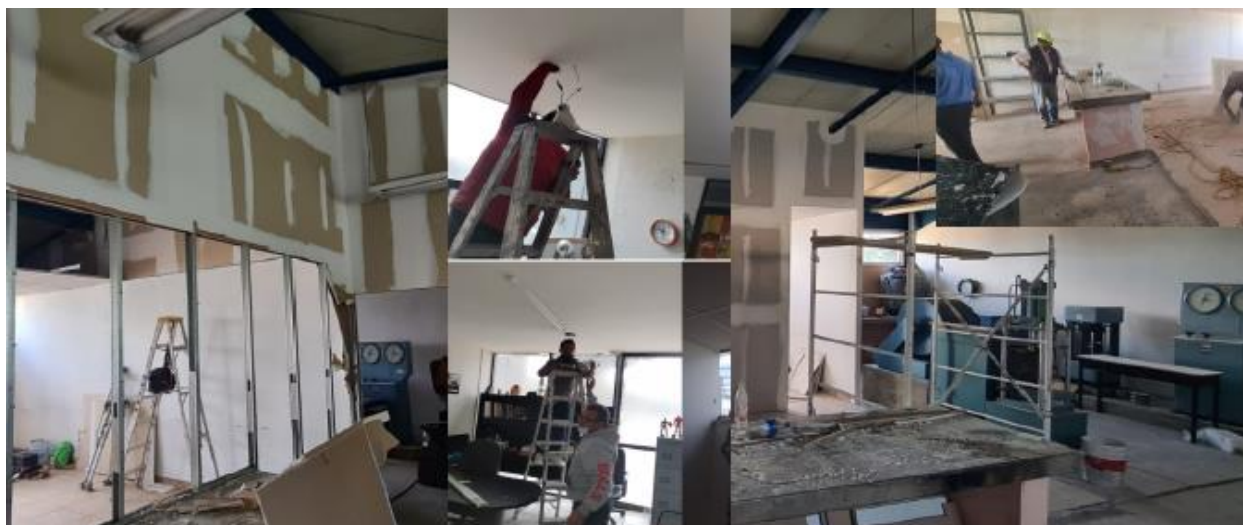
Imagen No. 86. Mantenimiento menor en infraestructura del Instituto Tecnológico de Zacatecas
