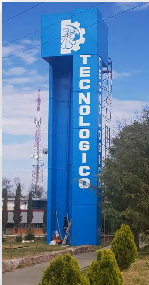
Imagen 16. Pintura y rotulado de Tanque elevado
