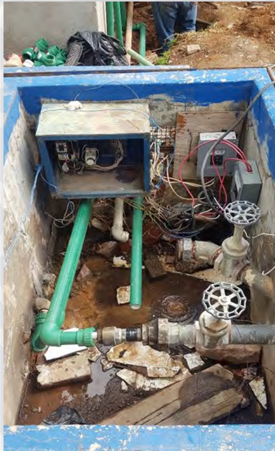
Imagen 16.7 Cambio de motobombas a cárcamo seco
